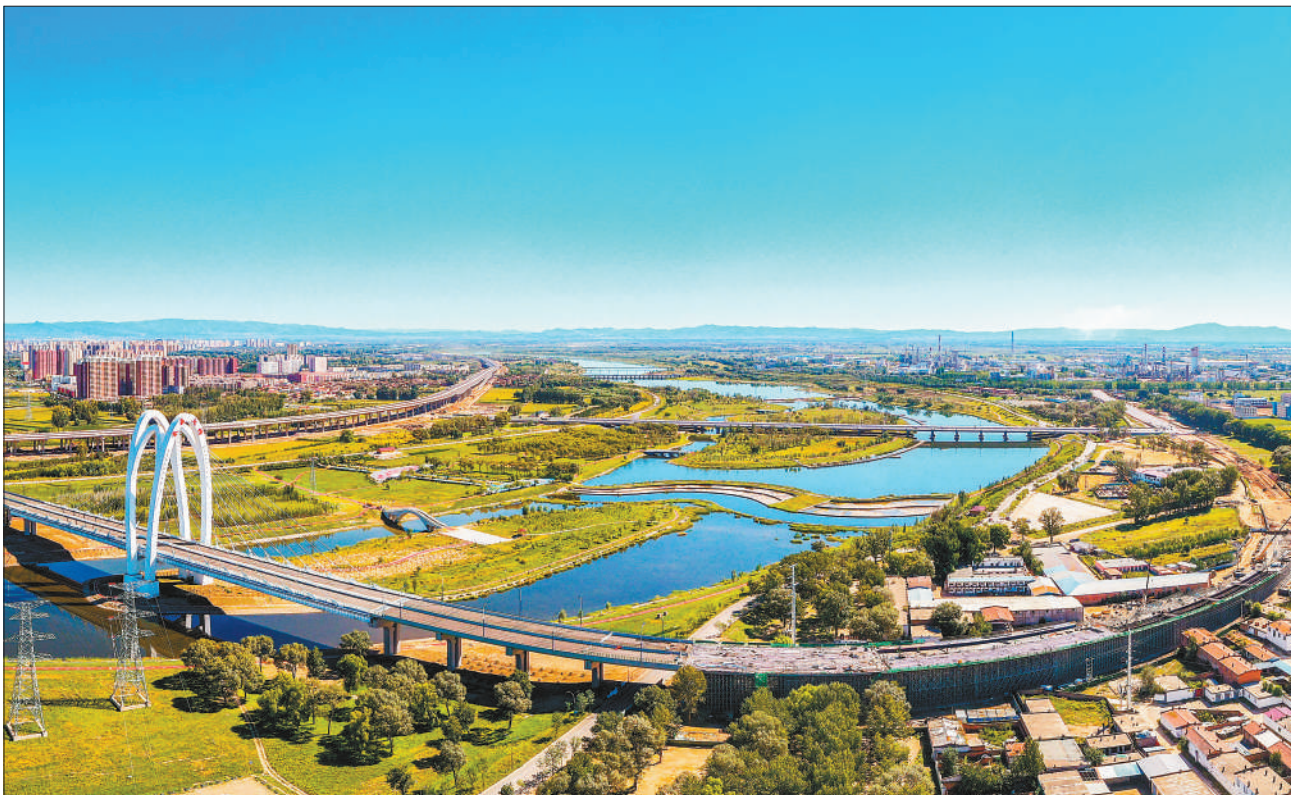
内蒙古自治区呼和浩特市不断加快市政道路基础设施建设,按照规划,今年将新建70余条道路,加快构建高效通畅的城市路网体系。其中,呼和浩特市和林格尔新区金盛快速路北段—杭盖路连接线项目正在有序推进,建成后将进一步缩短中心城区与和林格尔新区的通行时间,方便群众出行。 图为日前正在进行桥面浇筑作业的金盛大桥南段。 丁根厚摄(人民视觉)
