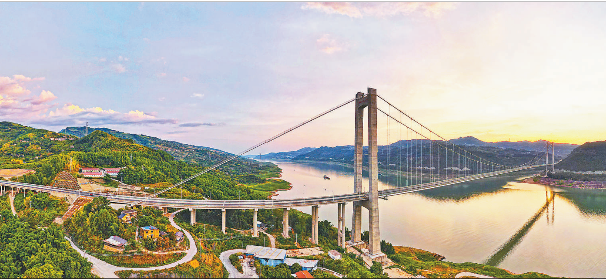
9月1日，恩（湖北恩施）广（四川广元）高速公路重庆万州新田至高峰段建成，并于9月2日凌晨开通运营，标志着万州80公里城市环线高速实现整体闭环。主跨1020米的新田长江大桥为三峡库区再添一座跨江通道，从万州新田到高峰的时间将由原先的一个小时缩短至15分钟。
