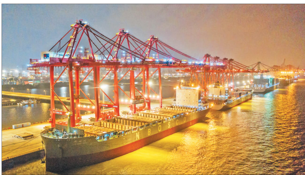
浙江省宁波舟山港北仑第一集装箱码头致力于数字化转型,推进智慧码头建设,提高物流效率。通过应用创新节能技术等举措,该码头实现泊位岸电设施全覆盖,LED节能灯具覆盖率高达94.38%,并配备了远程智能照明控制系统。图为宁波舟山港北仑第一集装箱码头作业现场。(蒋晓东摄(影像中国))
