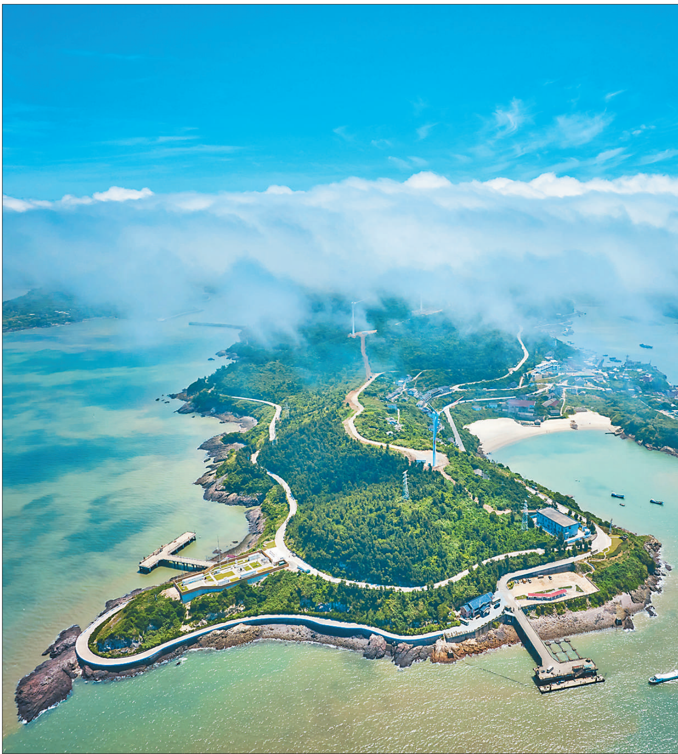
8月30日,浙江台州大陈岛氢能综合利用示范工程一隅。国家电网浙江台州大陈岛氢能综合利用示范工程是我国首个海岛“绿氢”综合能源示范工程。该工程实现了氢能与风力、光伏等可再生能源耦合运行,同时满足岛上生产生活用电、氢、热等多种能源需求,为我国海岛综合开发与生态保护提供了成功范例。史家民摄(影像中国)
