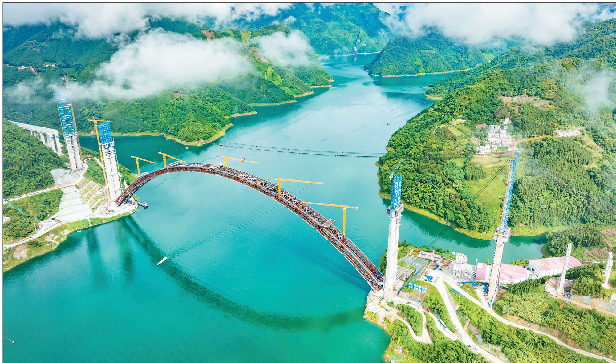
8月27日,在广西河池市天峨县,天峨龙滩特大桥建设有序推进。天峨龙滩特大桥是广西南丹至天峨下老高速公路项目的控制性工程,建成后将推动项目实现全线贯通。
