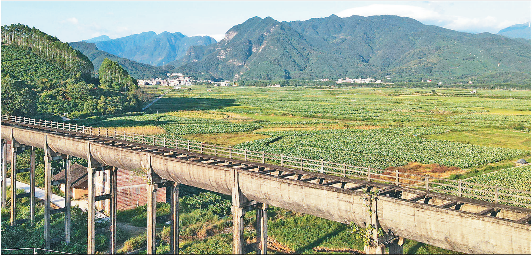
8月28日，湖南省江永县源口瑶族乡马鞍口村，源口水库右干渠渡槽正在引水抗旱。该渡槽于上世纪70年代末建成，多年来在保障江永县桃川、源口、兰溪3个乡镇3万多亩农田抗旱保收中发挥了重要作用。
