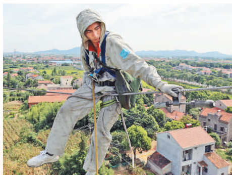
烈日炎炎，40米高的±800千伏特高压输电线上，胡洪炜(见上图，国家电网湖北电力超
