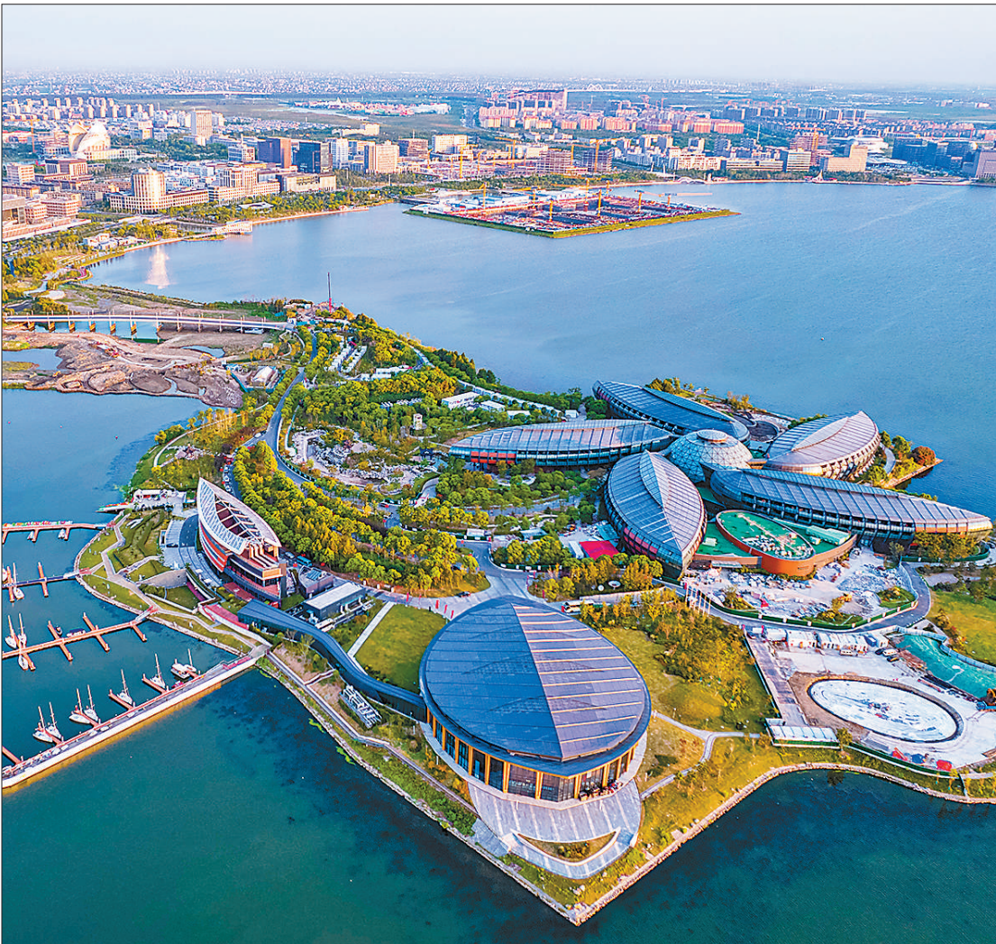
2019年8月，中国(上海)自由贸易试验区临港新片区挂牌成立。3年来，临港新片区贯彻新发展理念，坚持高质量发展，建设面貌日新月异，特殊经济功能加速孕育，收获了一批突破性、引领性改革创新成果。图为8月14日，临港新滴水湖畔，多个重点项目加快建设。
