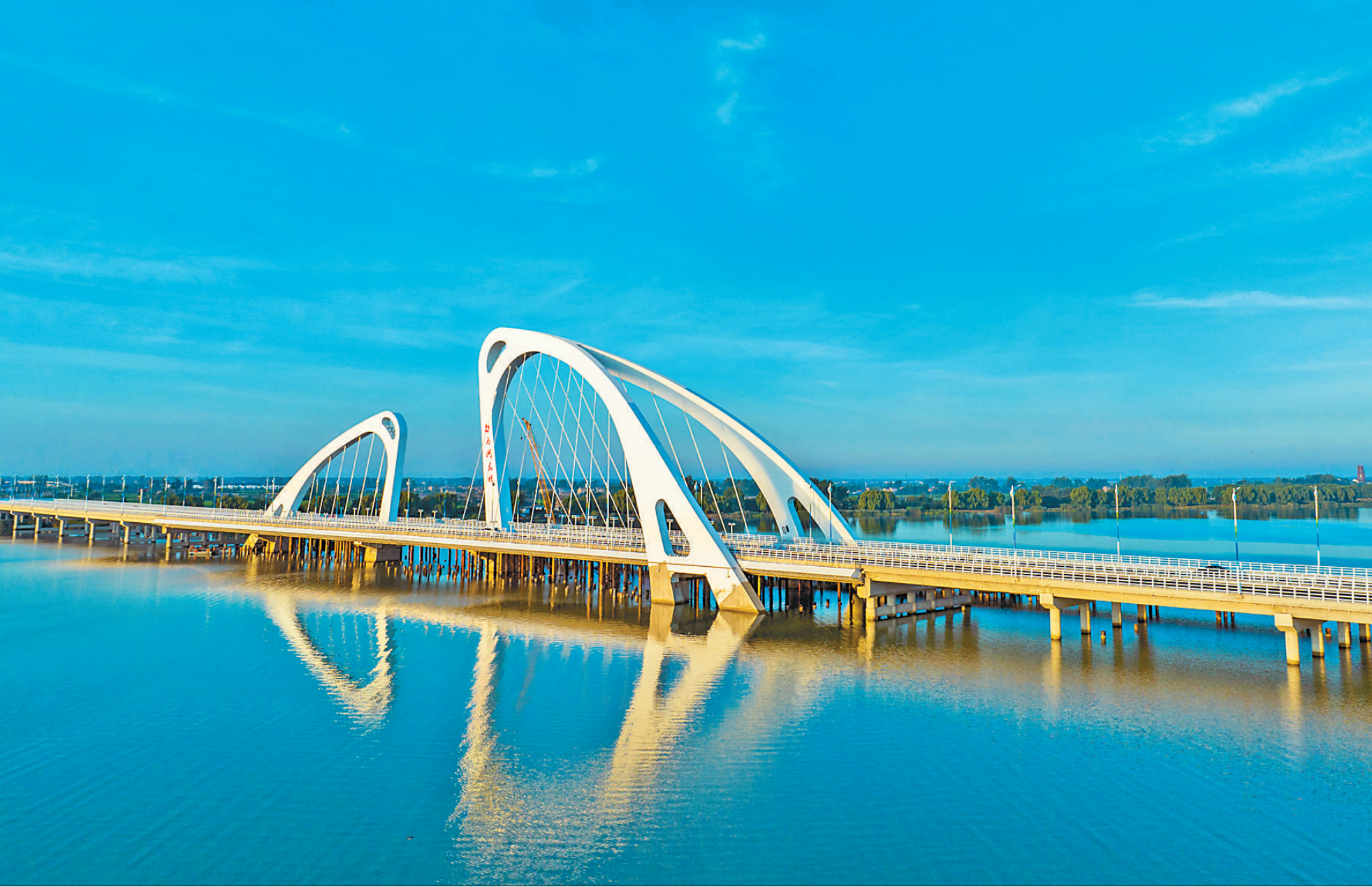
目前，江苏淮安白马湖大桥已进入亮化工程调试阶段。白马湖大桥主桥长246米、宽37米，两座拱塔宛若跃出湖面的白色双鱼。图为8月13日拍摄的白马湖大桥。贺敬华摄（影像中国）
