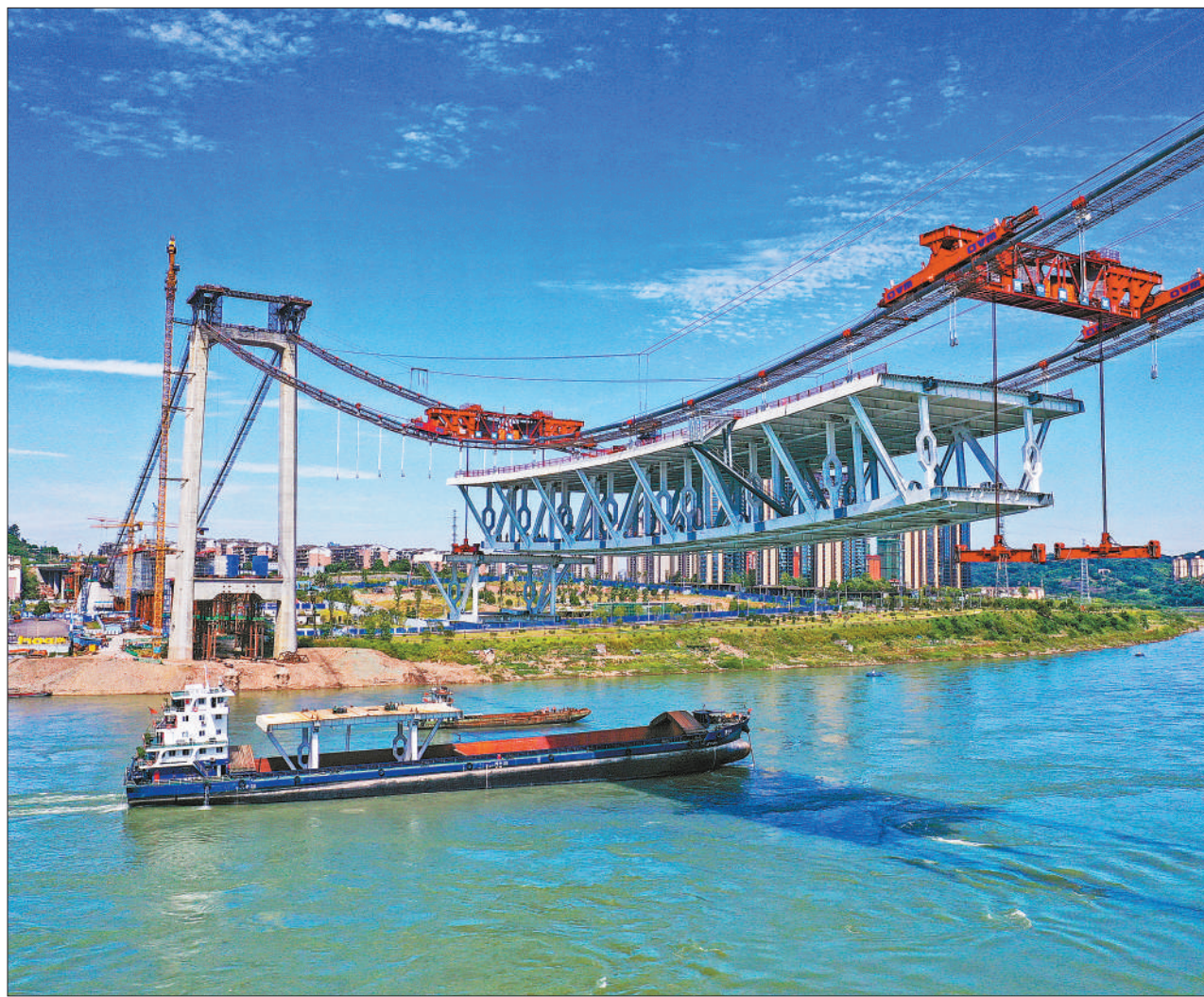
8月12日,四川省泸州市泸州长江二桥项目建设现场,正在进行钢桁梁吊装作业。泸州长江二桥是泸州首座双层公轨两用悬索桥,为双向八车道(上层六车道、下层两车道),预计9月底可完成全部钢桁梁吊装,力争明年具备通车条件。
