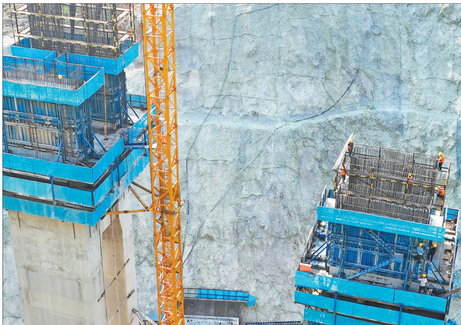
8月4日,渝湘复线高速阿蓬江大桥施工现场,工人正在施工。阿蓬江大桥位于重庆市酉阳土家族苗族自治县龚滩镇红花村,是渝湘复线高速彭水到酉阳段的控制性工程,大桥全长514米,是一座钢构施工的过江大桥,最高墩位达65米。
