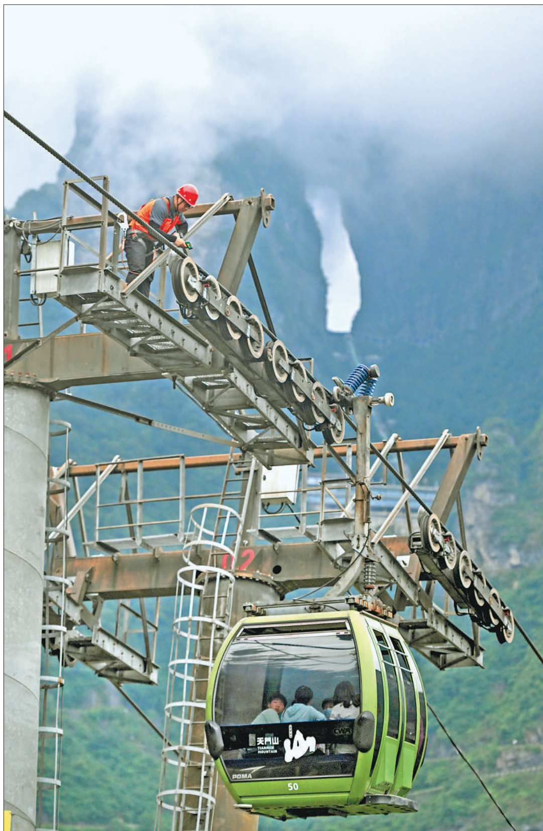
近日,湖南张家界天门山索道,检修工站在支架顶部进行检查维护工作。进入暑期旅游旺季以来,当地景区加大对高空客运索道、观光电车等配套服务设施的安全隐患排查力度,保障游客安全。(郭立亮摄(影像中国))
