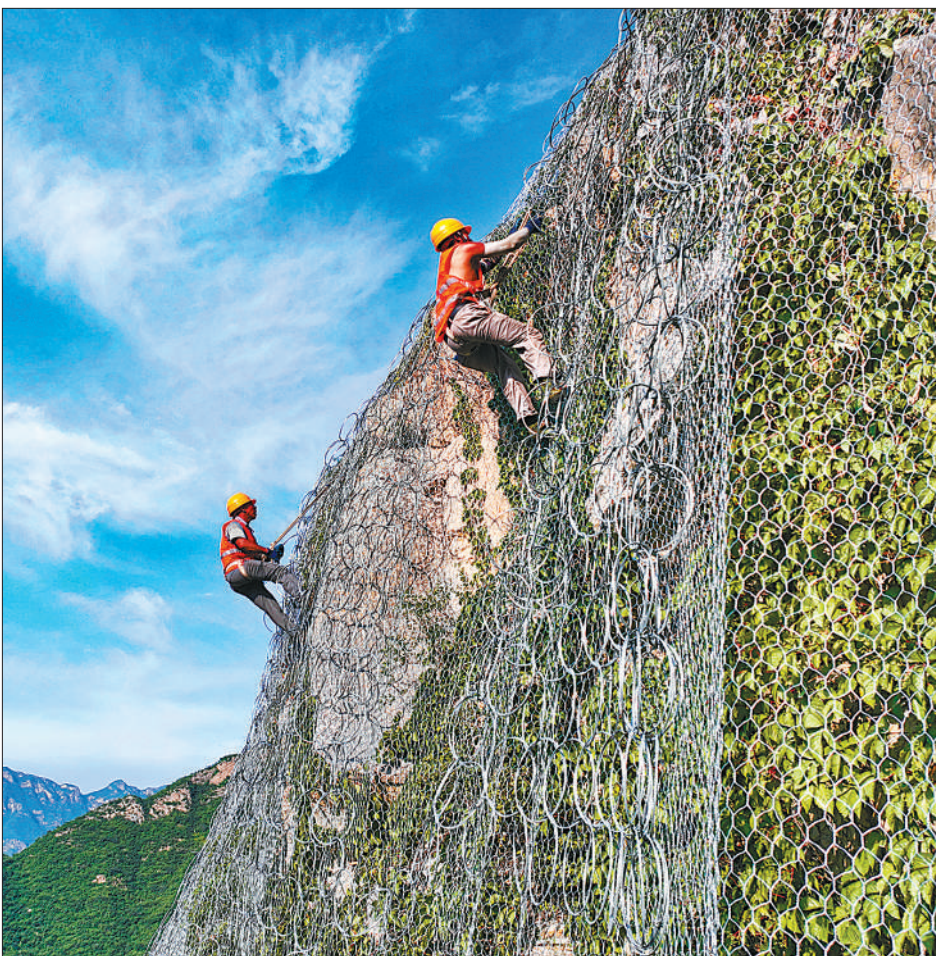
北京市交通委门头沟公路分局近期对11条公路82处地质灾害隐患点进行治理，通过安装柔性防护网等方式防止落石、崩塌，以实现最佳的边坡防护和环境保护。图为工人正在下安路崖壁上安装柔性防护网。
