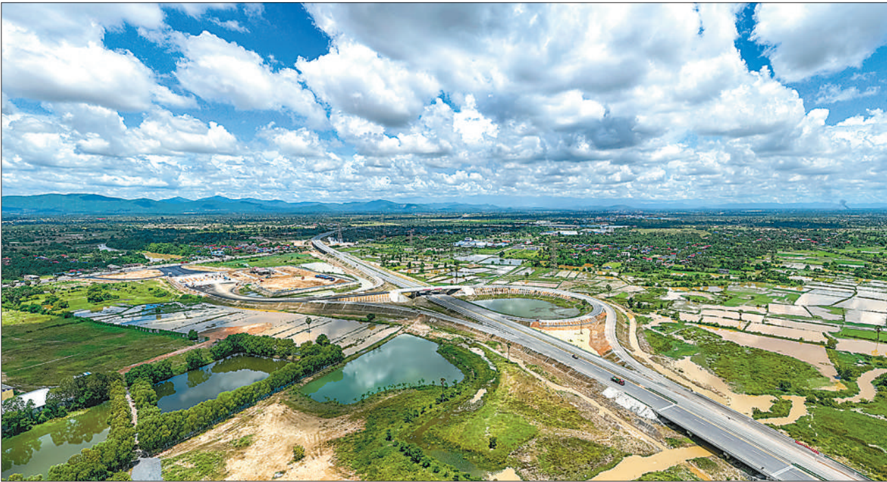
金港高速公路连接柬埔寨首都金边和最大深水海港西哈努克港,是中国路桥投资的建造—运营—移交项目,采用中国设计及质量标准,全长187.05公里,建成后两地车程将由5小时缩短至2小时以内。图为在柬埔寨磅士卑省拍摄的金港高速公路项目(无人机照片)。
