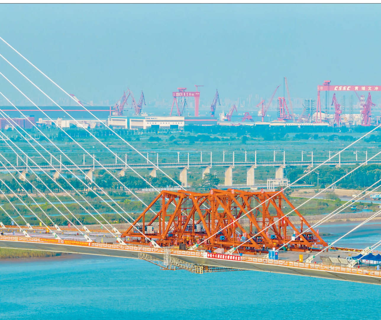
7月25日，随着最后一节重达113吨的钢箱梁精准吊装就位，粤港澳大湾区重点交通项目——广州南沙自贸区红莲大桥主桥顺利合龙。红莲大桥建成通车，将助力形成高效便捷的现代交通运输体系，对南沙自贸区加快融入粤港澳大湾区建设发挥重要作用。 魏动松摄(影像中国)
