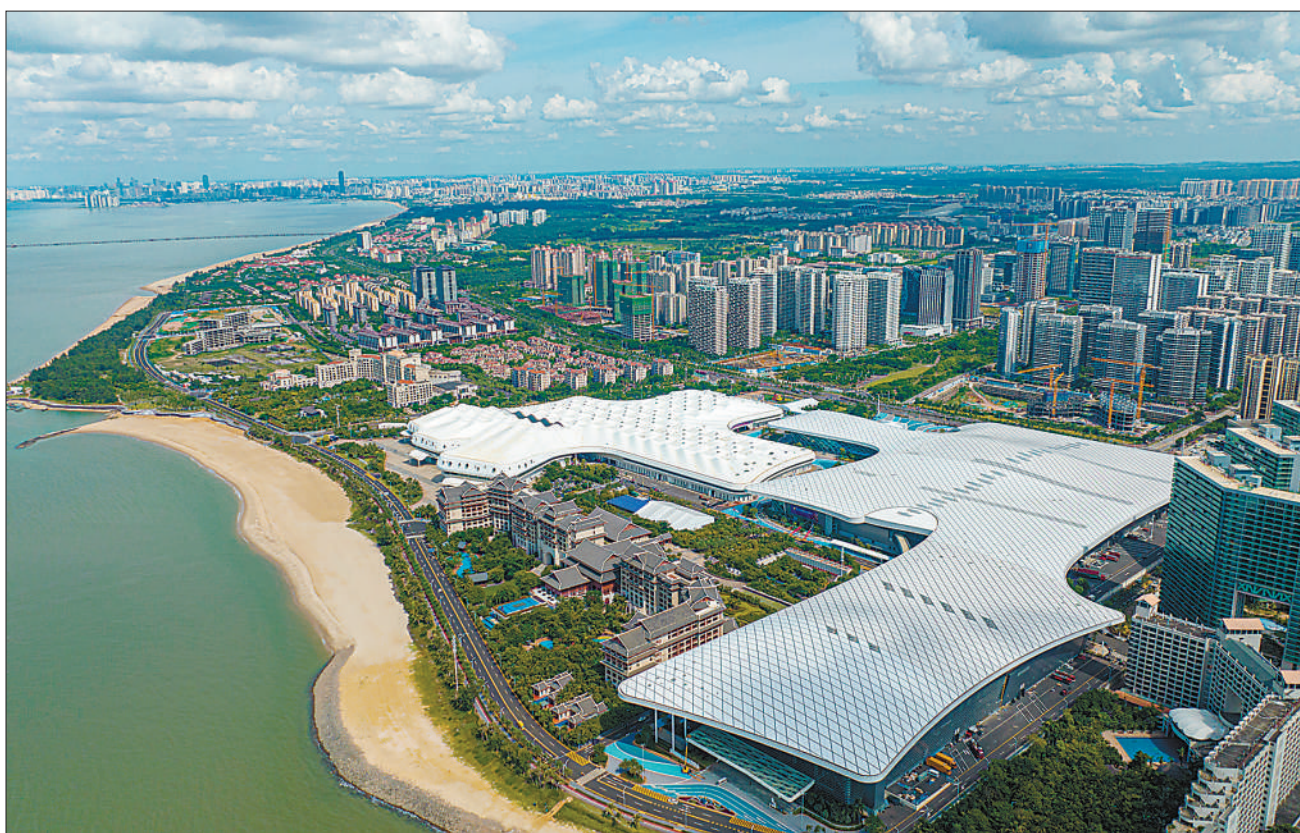
以“共享开放机遇，共创美好生活”为主题的第二届中国国际消费品博览会将于7月26日至30日在位于海南省海口市的海南国际会展中心举办。图为7月19日，俯瞰海南国际会展中心。
