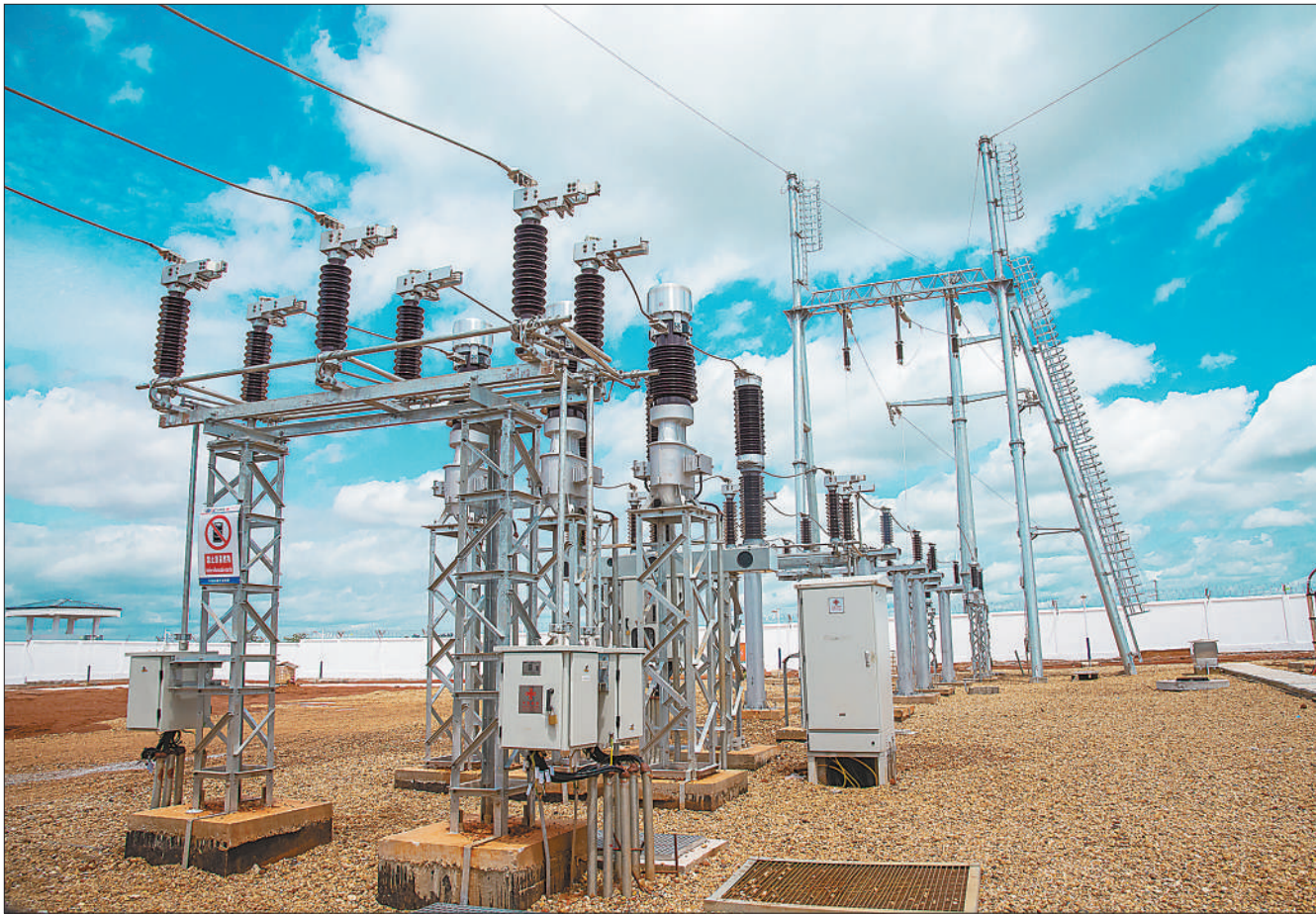
中国积极支持非洲应对气候变化的相关努力,推动非洲清洁能源合作项目。图为近日在中非共和国首都班吉附近的博博伊光伏电站的升压站。这座由中国援建的光伏电站极大缓解了中非共和国用电难的现象。新华社记者 罗毓摄
