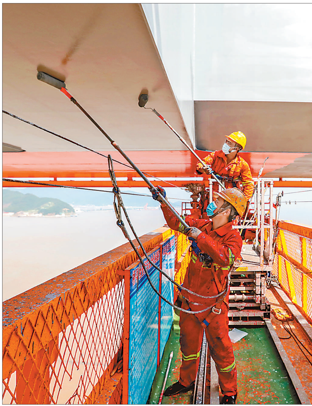
右图:7月12日,浙江舟山西堠门大桥,工人在狭小的桥梁桁架上为大桥钢箱梁打磨除锈、涂刷油漆。
