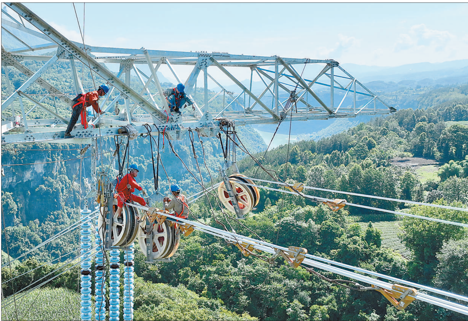
7月6日，湖北省恩施市新塘乡下塘坝村龙家台三溪口，白鹤滩—浙江±800千伏特高压直流输电工程施工现场，电力工人在清江河岸的铁塔输电线路紧张线和安装附件。该工程为白鹤滩水电站电力外送二期工程，起于四川省凉山彝族自治州布拖县，止于浙江省杭州市余杭区，线路全长2140.2千米。张远明摄(人民视觉)
