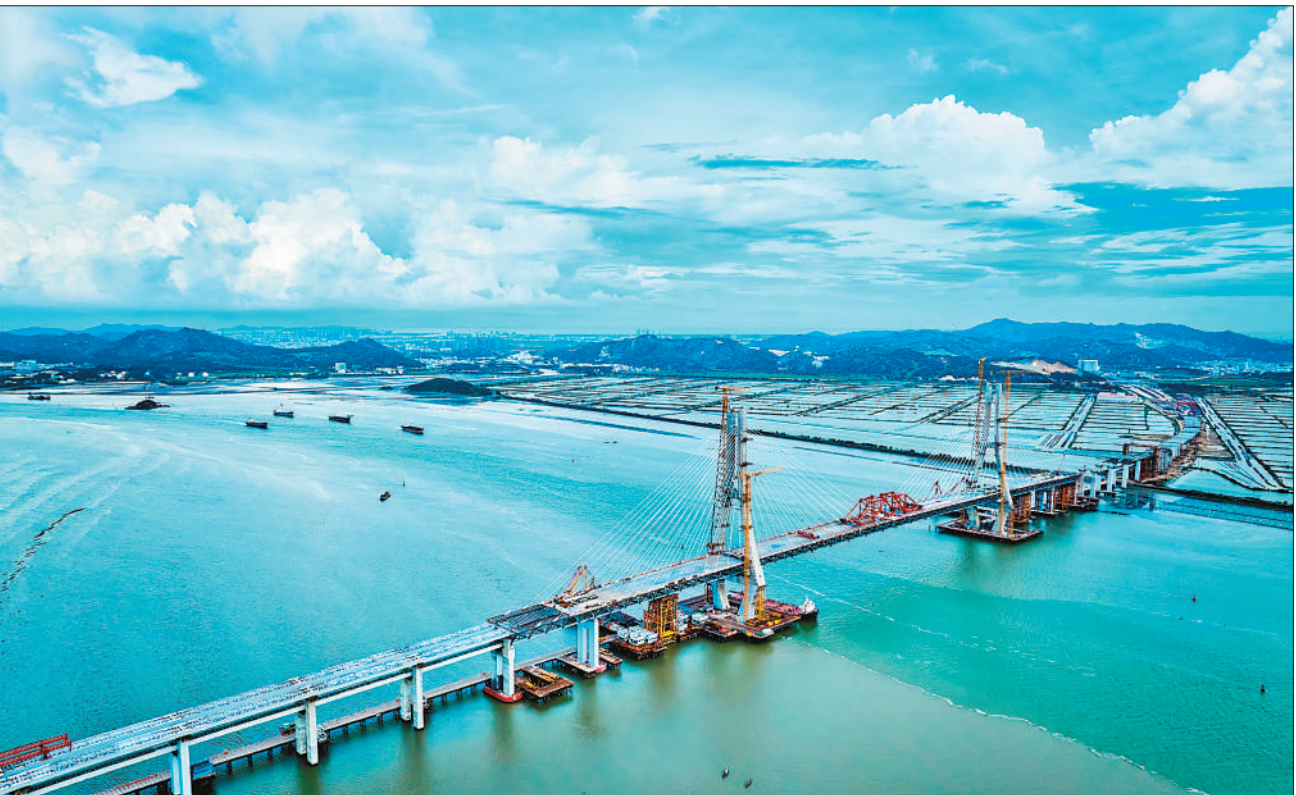
日前,广东省汕头市牛田洋特大桥主桥成功合龙。牛田洋特大桥是牛田洋快速通道重要组成部分,主桥全长955米、主跨468米,两个水中主塔塔高均为182.9米,目前为粤东地区主塔最高、跨度最大的双塔双索面钢桁梁斜拉桥。大桥上层为双向八车道一级公路,下层为双线跨座式轨道交通。图为牛田洋特大桥主桥合龙现场。
