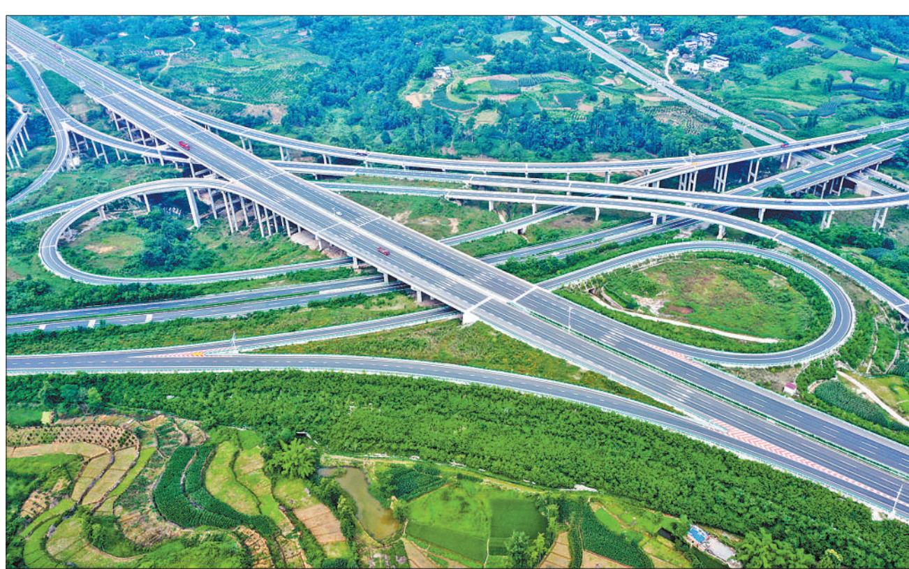
今年1至5月,我国完成交通固定资产投资1.2万亿元,同比增长4.9%。近年来,我国交通固定资产投资持续高位运行,为服务稳定经济大盘、做好“六稳”“六保”工作发挥了积极作用。 四川省眉山市仁寿县持续加强交通基础设施建设。交通路网在改善群众出行条件的同时,带动了产业发展,助力乡村振兴。图为仁寿县内的交通枢纽。 潘 帅摄(影像中国)
