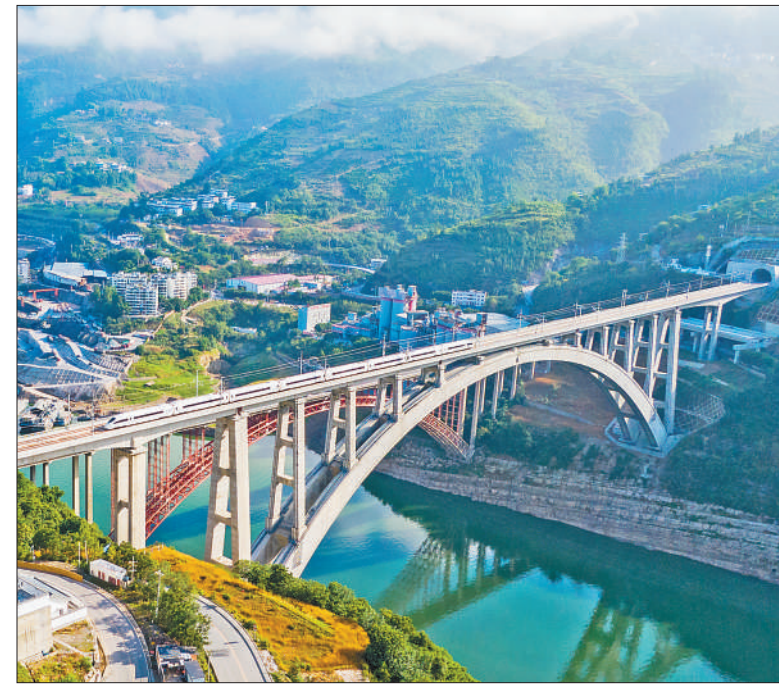
6月20日，郑渝高铁全线开通，一辆列车行驶在重庆奉节梅溪河双线特大桥上。舒鹏摄（新华社发）
