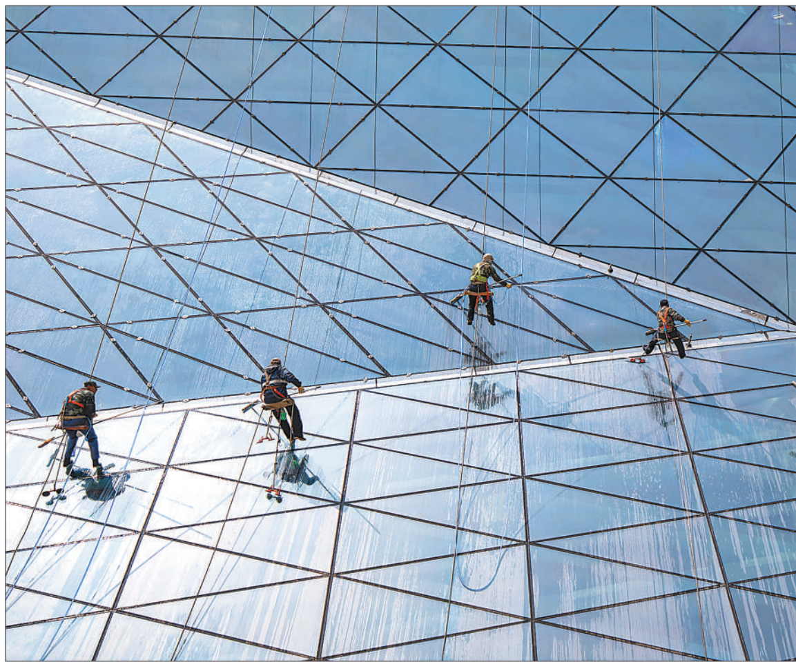
6月16日,辽宁省沈阳市沈河区,工作人员在为盛京大剧院清洗外立面。剧院采用3万平方米超大玻璃幕墙的设计,新颖独特。剧院与周边的公园等设施共同形成集文化、休闲等为一体的特色产业带,平时吸引不少市民、游客前来。侯伟摄(影像中国)
