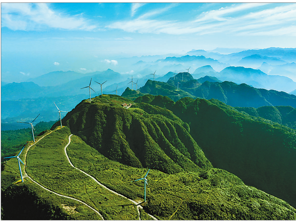
6月14日，在重庆市万盛经开区南天门风景区风力发电场，一座座风力发电机矗立在山脊上，源源不断输送绿色能源。近年来，当地加快推动资源型城市转型升级，大力发展风电，助力经济社会高质量发展。曹龙龙摄（人民视觉）
