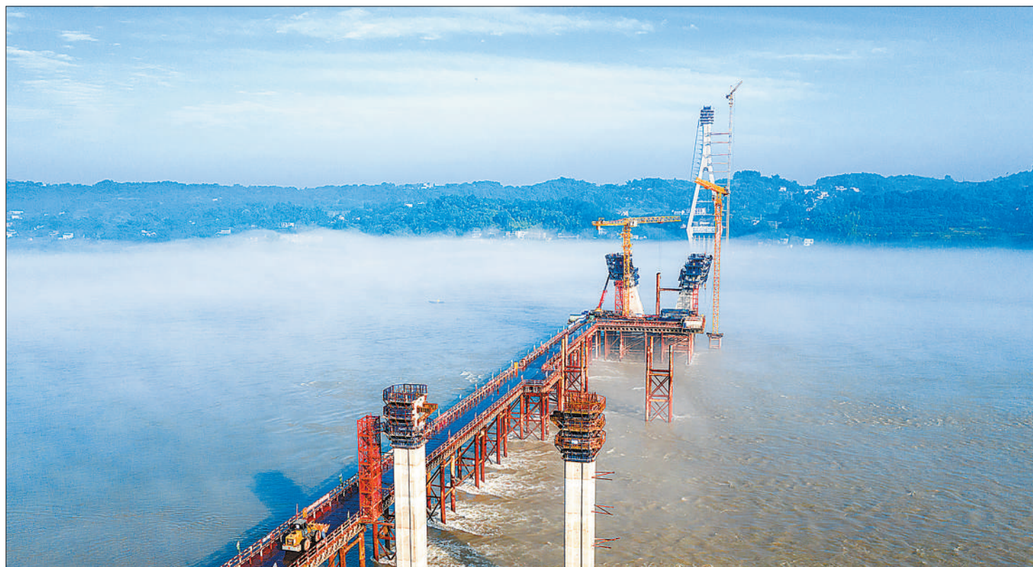
6月14日,四川省泸州市合江县的榕山长江大桥项目建设现场,大桥2号主墩及承台正在施工。榕山长江大桥南岸连接榕山临港工业园,北岸将与宜泸渝高速公路互通立交连接。李贵平摄(影像中国)
