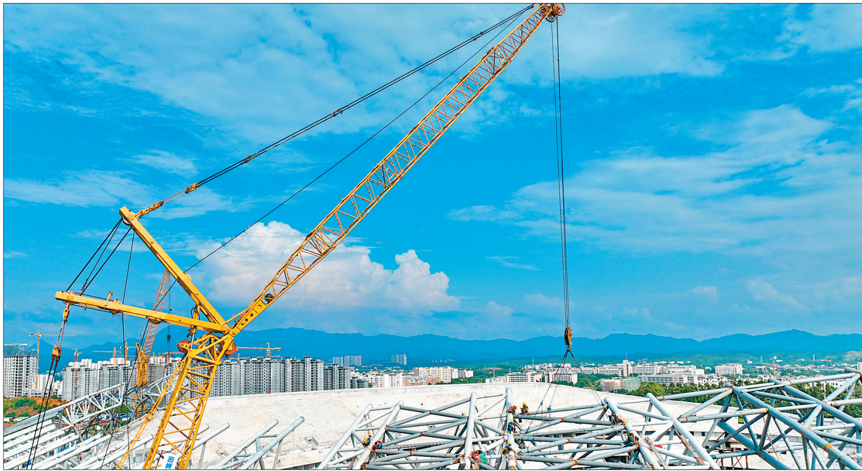
6月10日,江西省赣州市全民健身中心项目建设工地,施工方正在高空架设主场馆外围和顶棚钢架。近年来,赣州市大力发展体育产业,不断提高人民健康水平,通过完善体育场馆设施,推动竞技体育、运动健身消费提质扩容,激发供给侧结构性改革的强大动力。 朱海鹏摄(人民视觉)
