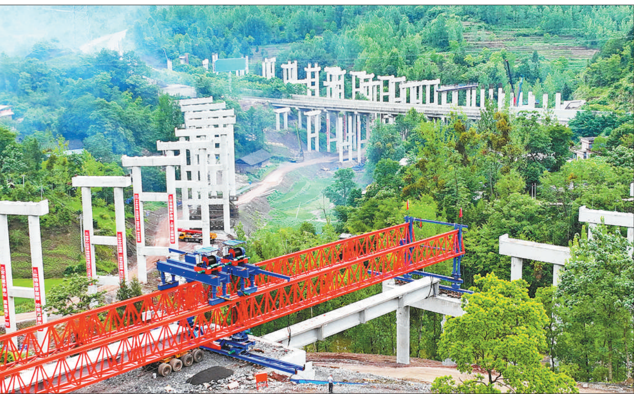
重庆市酉(阳)彭(水)高速公路铜西互通段建设工程稳步推进。酉彭高速建成后，从酉阳到重庆主城的时间预计将缩短至3小时以内。图为6月12日，互通项目的桥墩上架设预制桥梁。陈碧生摄(人民视觉)
