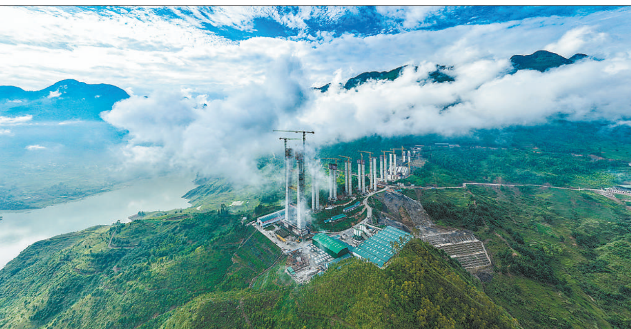
6月9日,贵州省晴隆县,纳雍至晴隆高速公路群阿江特大桥正加紧建设。纳晴高速公路全长160余公里,将串联起杭瑞、厦蓉和沪昆等国家高速公路主线。 邓刚摄(影像中国)
