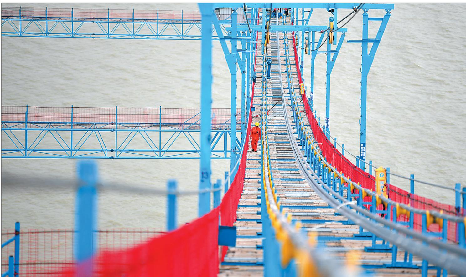
6月7日，工人在深中通道伶仃洋大桥海上施工猫道上作业。据了解，深中通道预计2024年建成通车，工程采用东隧西桥方案，全长24公里，是粤港澳大湾区超级跨海集群工程之一，建成后将成为连接珠江口东西两岸的直联通道。目前，深中通道各项建设正有序推进。 新华社记者 邓华摄
