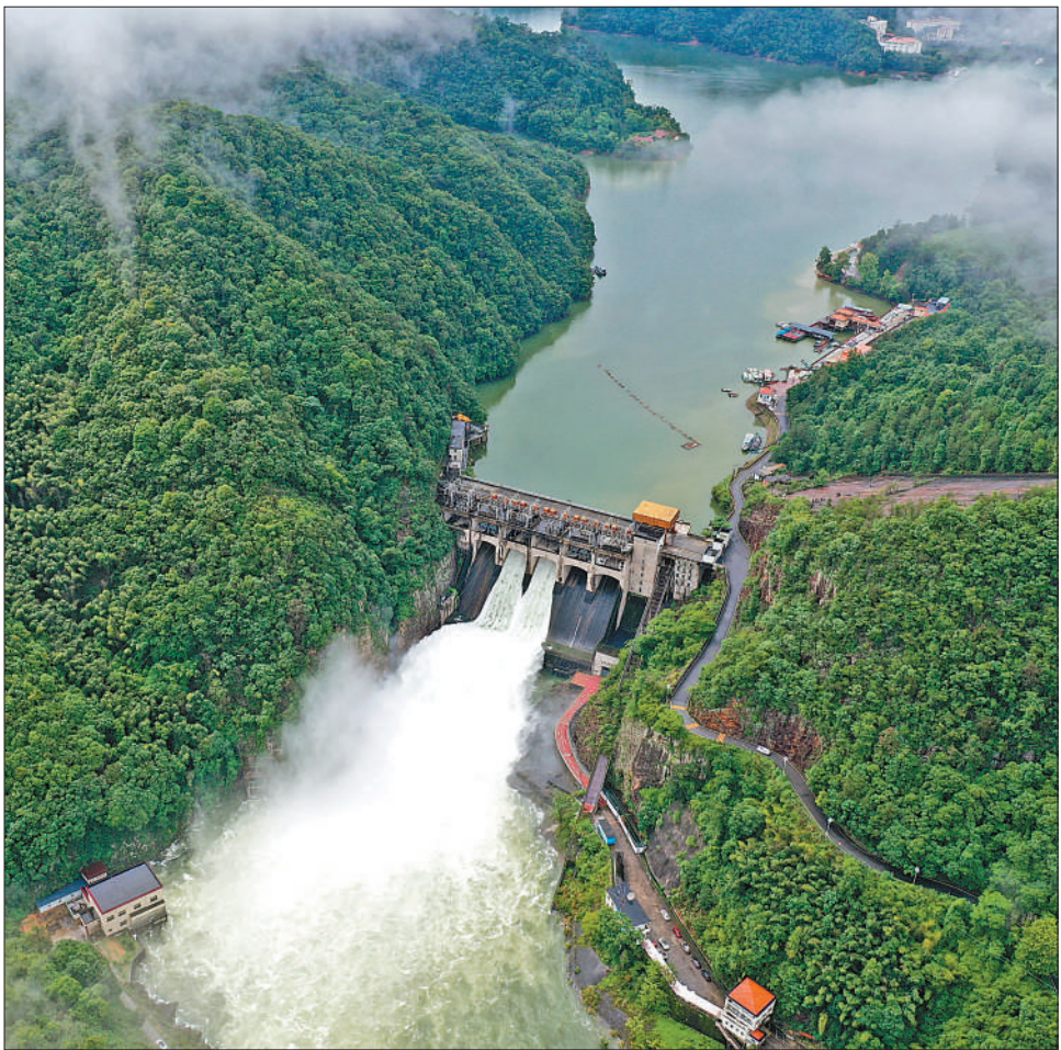
6月4日，在江西省上犹县，上犹江水电厂开闸泄洪，腾库迎峰，确保安全度汛。 钟芳亿摄(影像中国)
