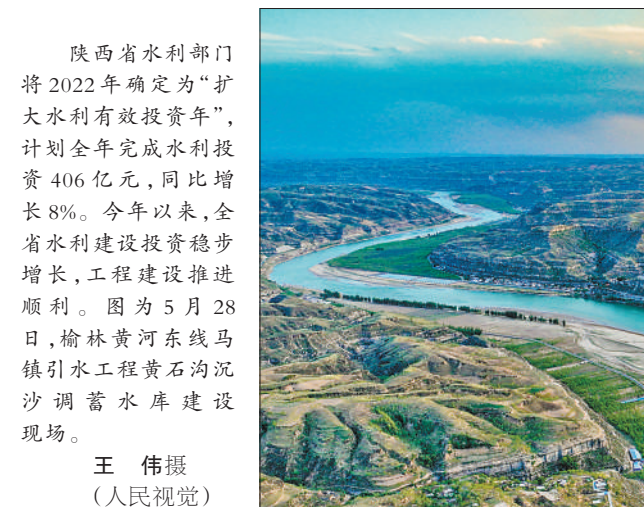
陕西省水利部将2022年确定为“扩大水利有效投资年”,计划全年完成水利投资406亿元,同比增长8%。今年以来,全省水利建设投资稳步增长,工程建设推进顺利。图为5月28日,榆林黄河东线马镇引水工程黄石沟沉沙调蓄水库建设现场。王伟摄(人民视觉)
