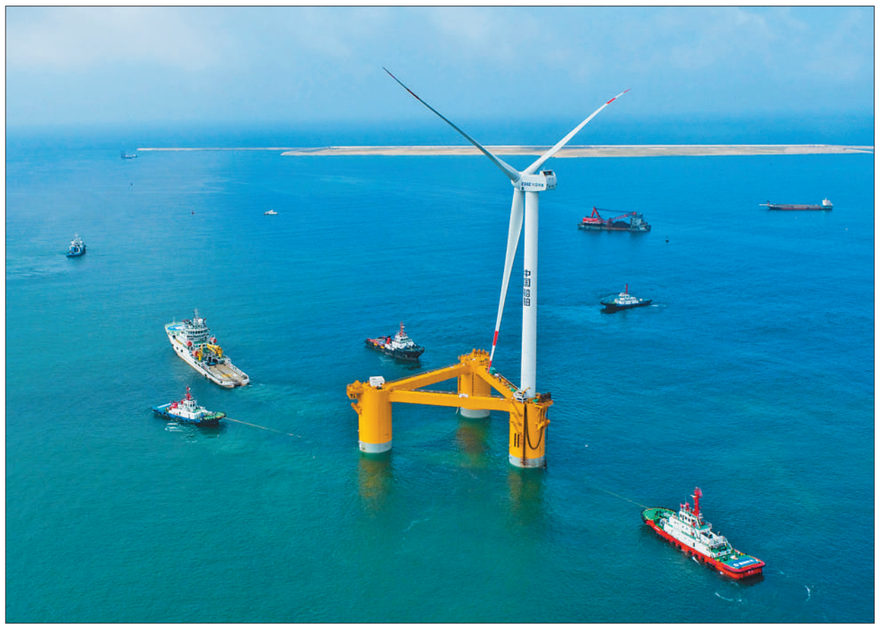
5月29日，国内首台深远海浮式风电装备“扶摇号”从广东茂名广港码头启航，前往湛江罗斗沙海域进行示范应用。由中国船舶集团海装风电股份有限公司牵头，联合相关单位自主研制的“扶摇号”浮式风电机组浮体平台上配备6.2兆瓦抗台风型风力发电机组，在深远海应用场将依靠9个对称分布的悬锚链系泊实现固定。新华社记者 刘大伟摄
