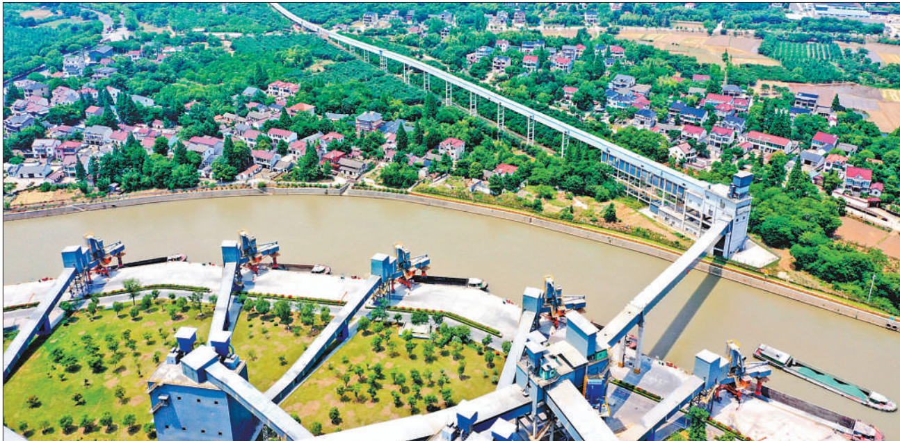
浙江省湖州市长兴县坚持生态优先、绿色发展,用全长22公里的全封闭自动化输送带将水泥熟料从生产线输送到码头,每天可减少3000辆次的重型货车运输,清洁低碳。
