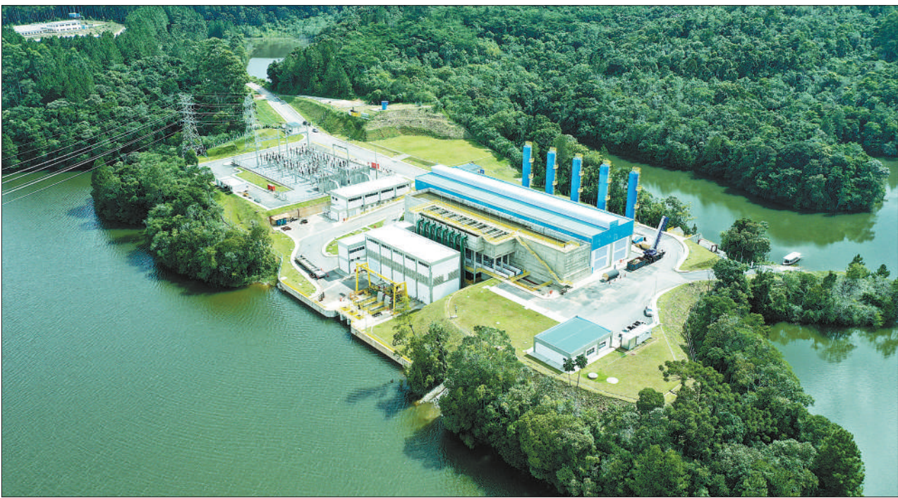
巴西圣诺伦索供水项目位于巴西圣保罗州伊比乌纳市,由中国能建葛洲坝集团投资并负责运营。项目商运4年多来,日供水能力达到约40万吨,保障了圣保罗市约200万人日常用水,极大改善圣保罗都市圈西部地区的供水能力。图为圣诺伦索供水项目全景。
