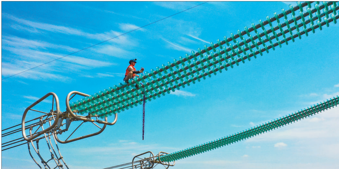
5月17日，在雅中至都阳湖特高压直流输电工程江西省吉安市峡江县段，电力工人在对输电线路进行检修。据了解，此次检修采取全检全试方式进行，保障夏季用电高峰输电通畅。陈福平摄(影像中国)
