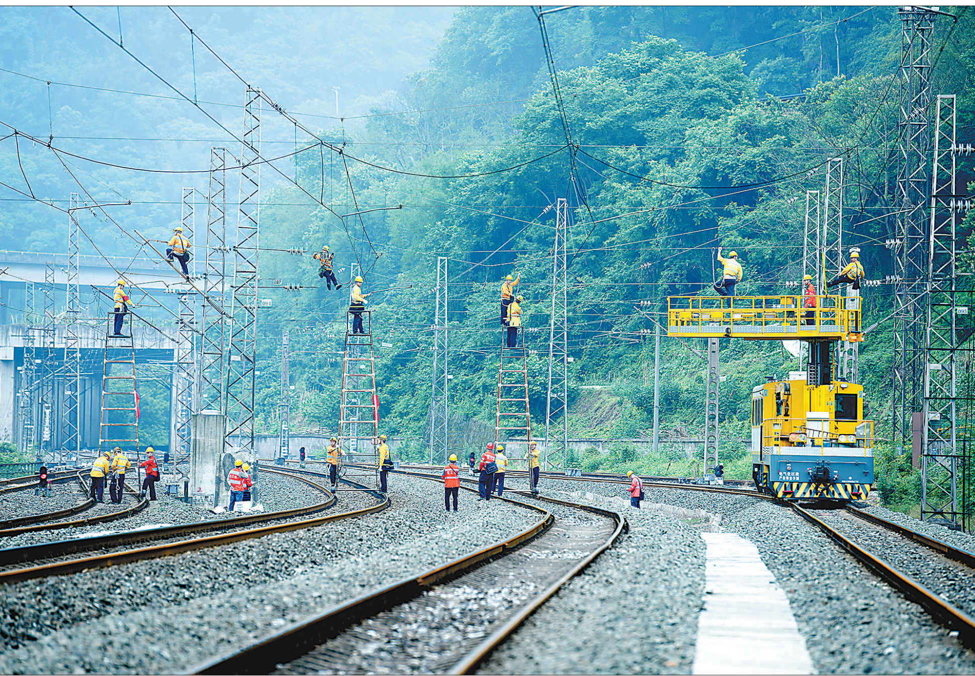
5月12日,中国铁路成都局集团有限公司宜宾工电段供电维修技术中心组织多名职工,对内昆铁路水富站接触网关键设备进行检修,保障铁路安全畅通。
