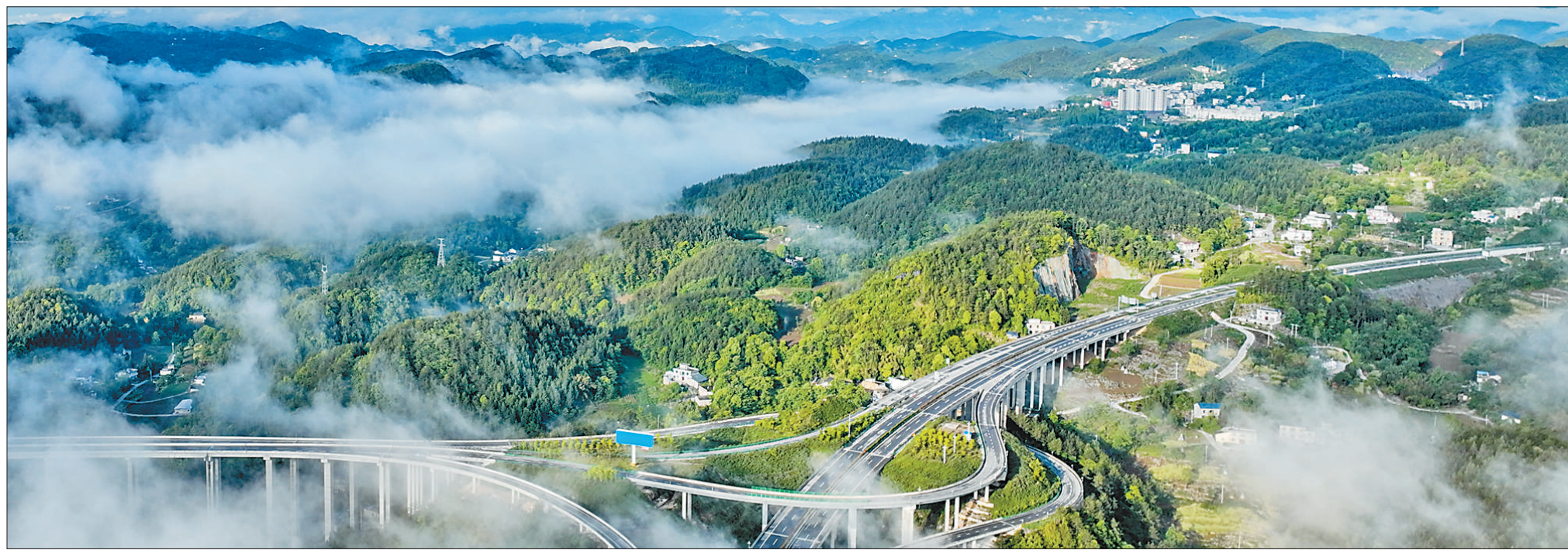
5月10日,湖北省恩施土家族苗族自治州建恩高速公路(建始县—恩施市)白杨坪枢纽互通段美景如画。近年来,恩施州高速公路建设不断提速,山区交通得到改善,为经济发展注入了活力。张远明摄(人民视觉)
