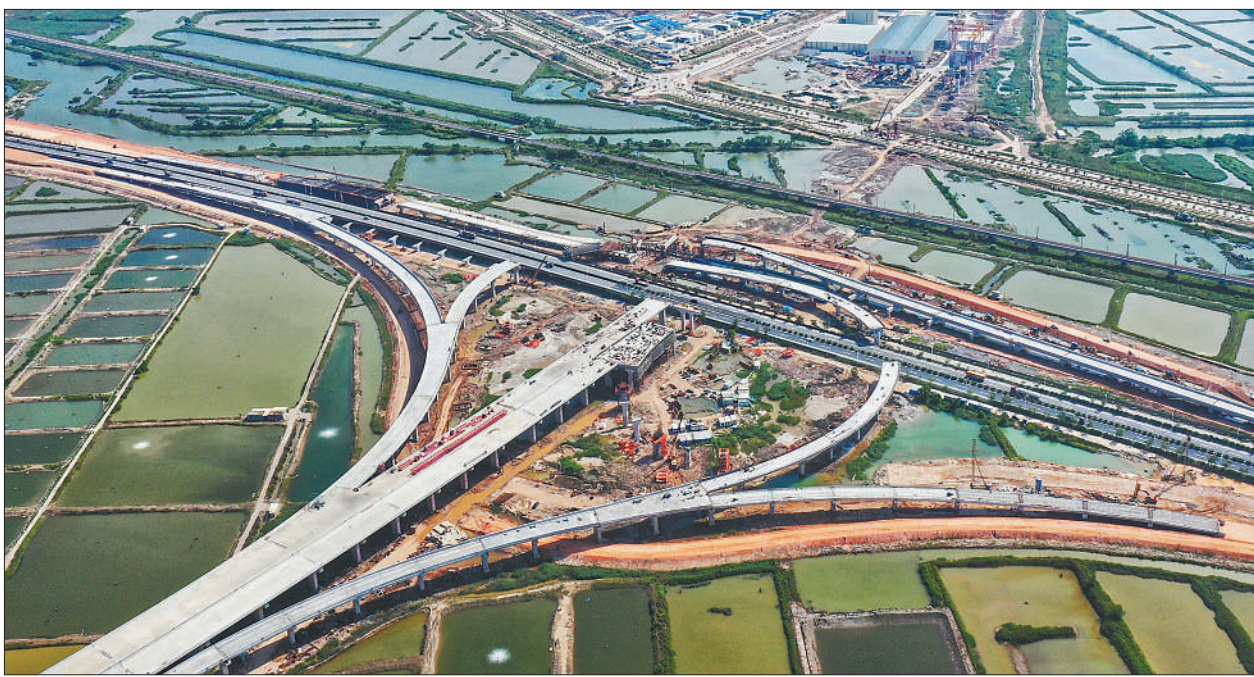
由中铁十一局施工的珠海鹤洲至高栏港高速公路二期工程高栏港枢纽立交桥临近竣工,即将对接珠江崖门海口黄茅海大桥陆上引桥。鹤洲高速全长35公里,东起港珠澳大桥连接线,西至珠海高栏港,项目建成后将成为珠江口西岸地区快速对接粤港澳大湾区核心区域的主通道。图为5月5日拍摄的珠海鹤洲高速公路二期工程高栏港枢纽立交桥建设现场。 新华社记者 刘大伟摄
