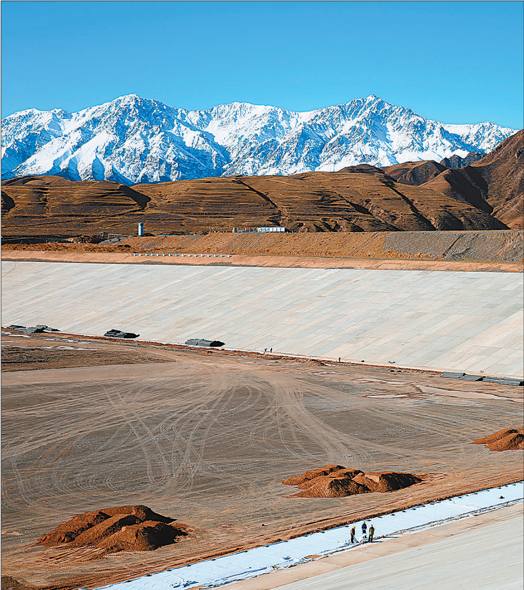
5月3日，在甘肃省张掖市甘州区酥油口下库工程建设工地，库体浇筑、防渗施工作业正抓紧进行。该工程预计今年7月竣工验收，届时，酥油口下库与上库联合调度，将为干旱缺水的安乡、花寨乡提供饮水和农业灌溉用水。
