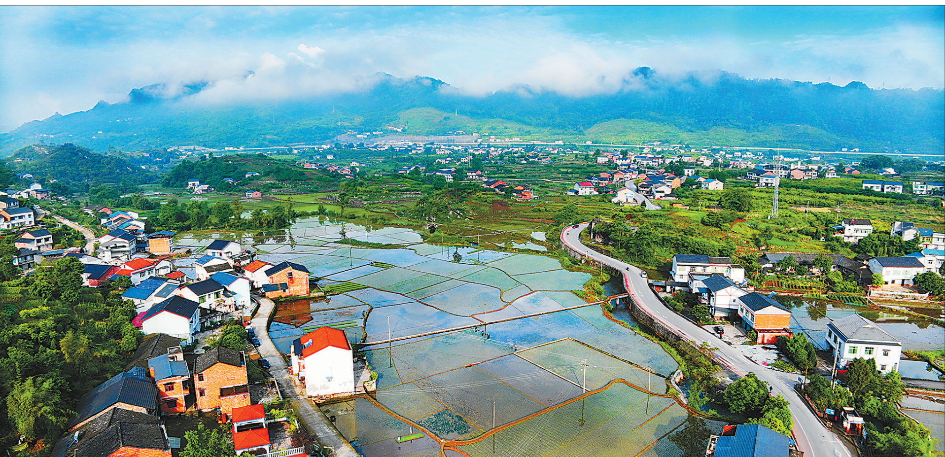
近年来,重庆万盛经开区加快采煤沉陷影响区生态环境修复,把绿色还给矿山,通过大规模开展山体植被恢复、危岩治理、水资源恢复、土地整治等生态修复工程,治理成效明显。图为5月4日拍摄的采煤沉陷影响区新貌。
