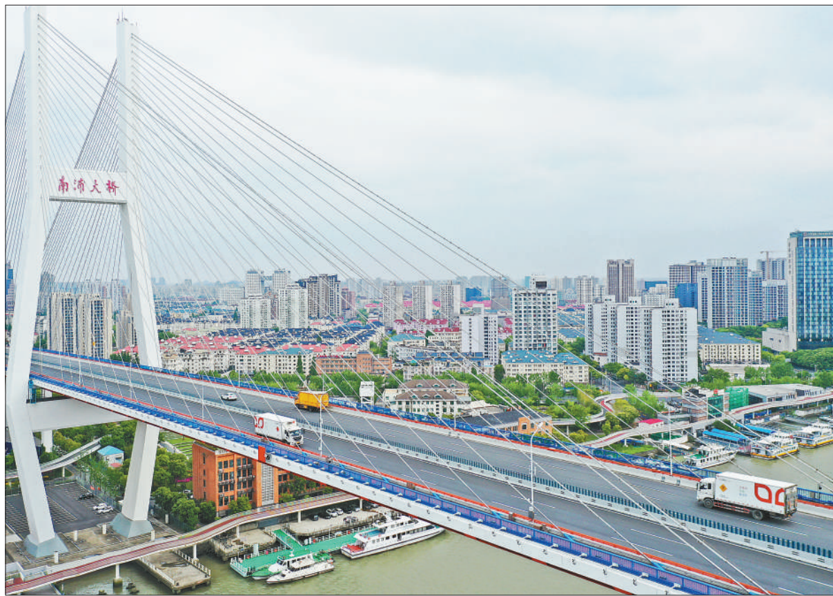
4月30日，白色全封闭式医废运输车行驶在上海南浦大桥上。上海本轮疫情发生以来，涉疫垃圾大幅增长。为筑牢疫情防线，上海持续提升涉疫垃圾收运处置能力，保障“日产日清”。新华社记者 李贺摄
