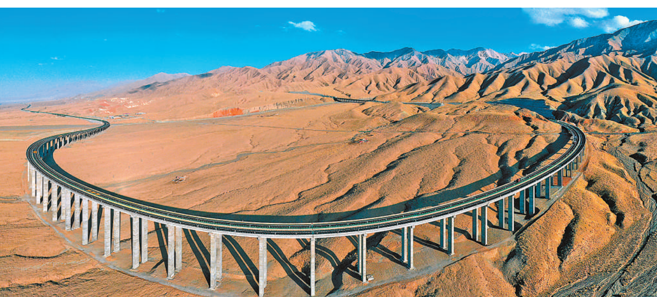
4月29日，作为连接甘肃、青海两省重要通道的敦煌至当金山口高速公路正式全线通车运营，连霍高速、京藏高速以及兰新高铁、敦煌铁路因此实现互联互通，西部地区路网结构进一步优化完善。图为当日拍摄的敦煌高速红崖子沟特大桥。
