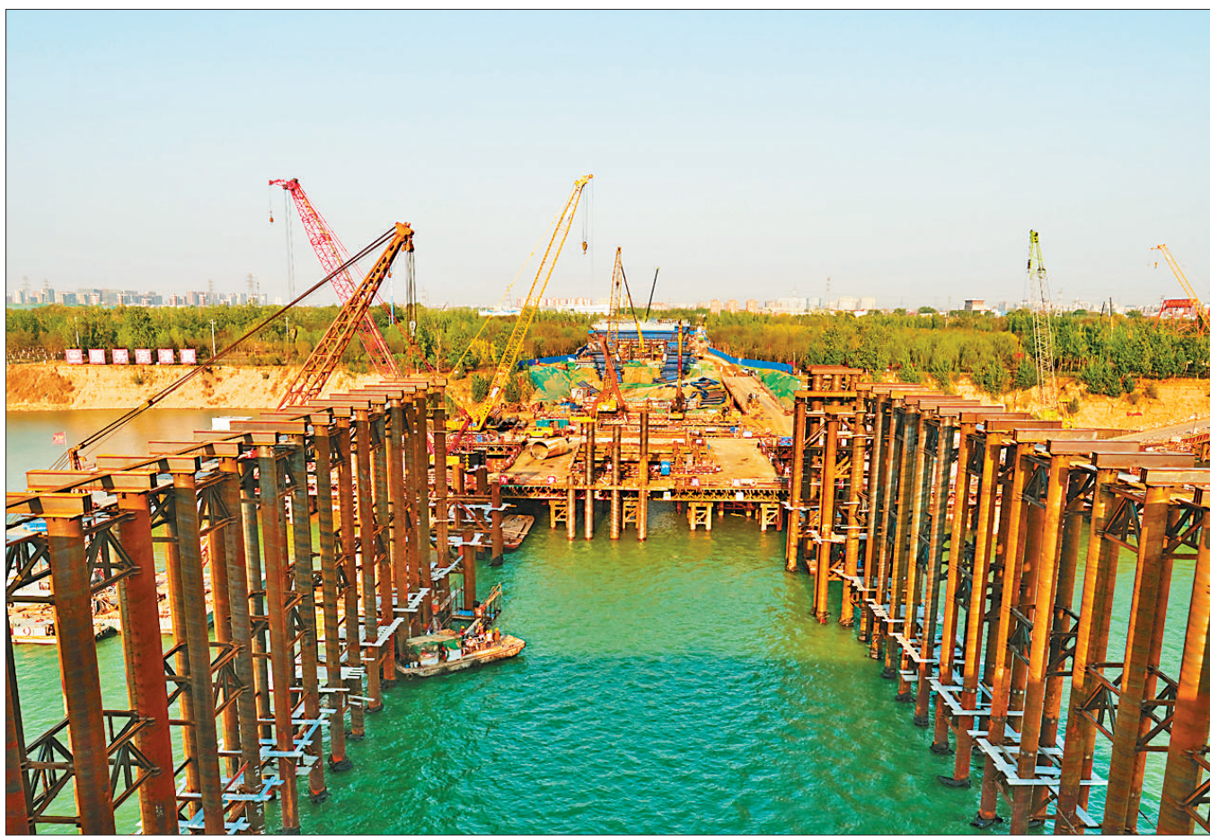
日前，京雄高速永定河特大桥主桥首个主墩承台正式开始浇筑施工。京雄高速公路是北京连接雄安新区的快速交通走廊，建成后将对完善雄安新区对外骨干路网、构建北京雄安“1小时交通圈”具有重要意义。图为建设中的永定河特大桥。
