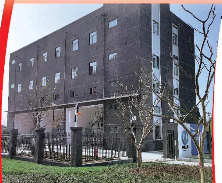
三峡东岳庙数据中心 35KV 变电站
