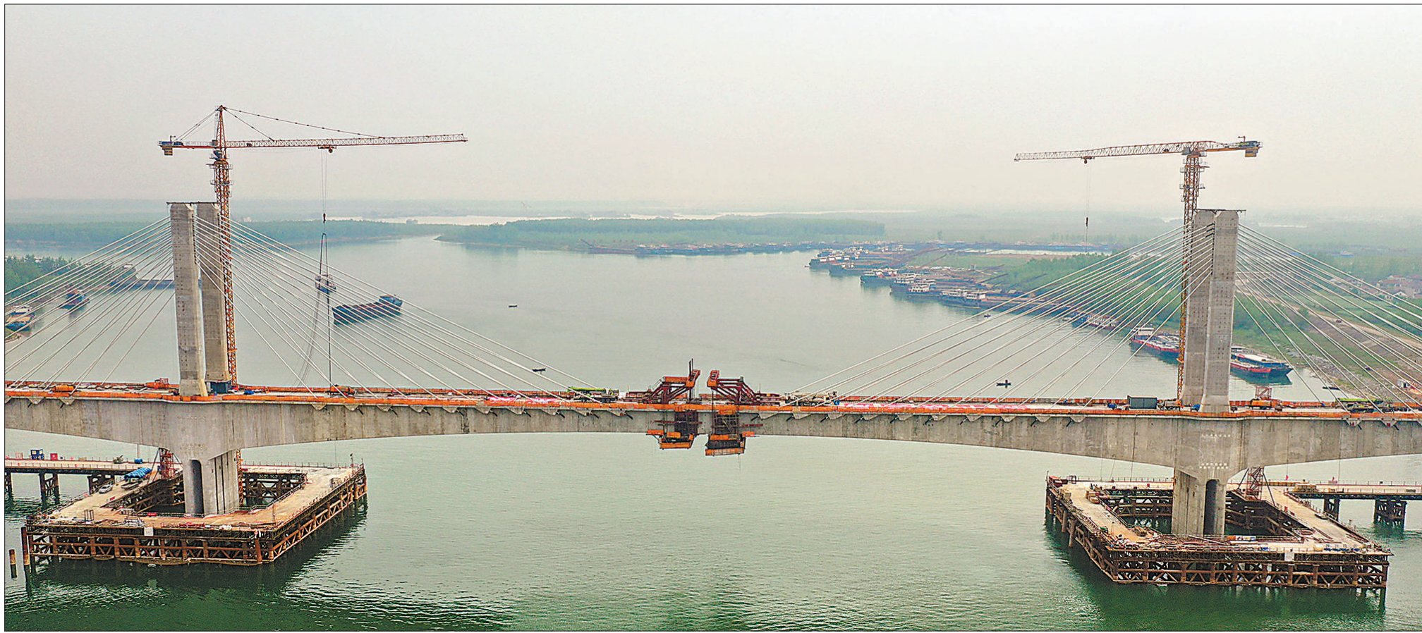
4月12日，湖南省常德市，常益长高铁沅江特大桥主跨完成合龙施工。当天凌晨，随着最后一方混凝土成功入模，由中铁三局承建的常益长高铁关键控制性工程——沅江特大桥主跨顺利合龙，实现全桥贯通。至此，常益长高铁主体工程基本完成，为全线铺轨奠定基础。
