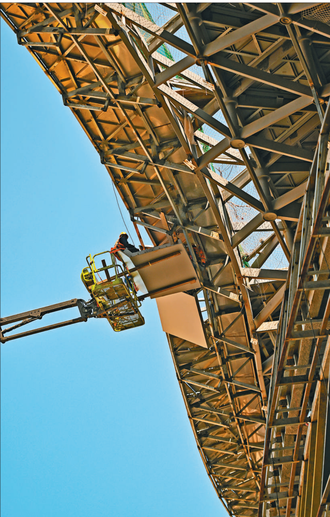
4月10日，工人在海南海口国际免税城项目工地施工。近日，免税城的免税商业中心造型屋面完成合龙，目前在进行室外园林景观及室内装修等施工。免税城项目总建筑面积约92.6万平方米，预计今年正式投入使用。
