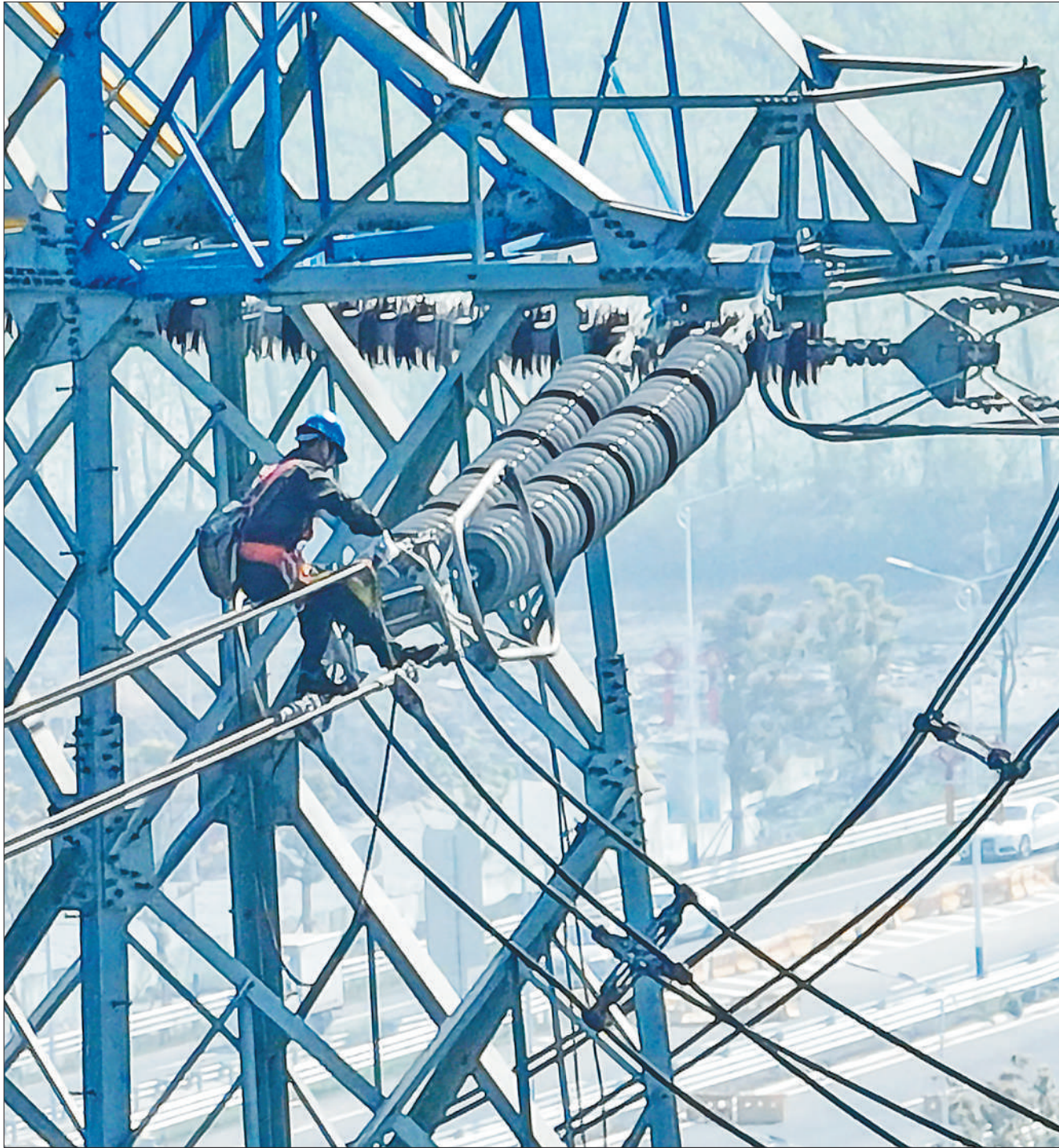
4月11日，江苏省泰州市姜堰区500千伏凤伸、凤阳线路春检施工现场，电力工人正在进行高空作业，确保“北电南送”主通道及长三角地区能源可靠供给。 汤德宏摄(人民视觉)
