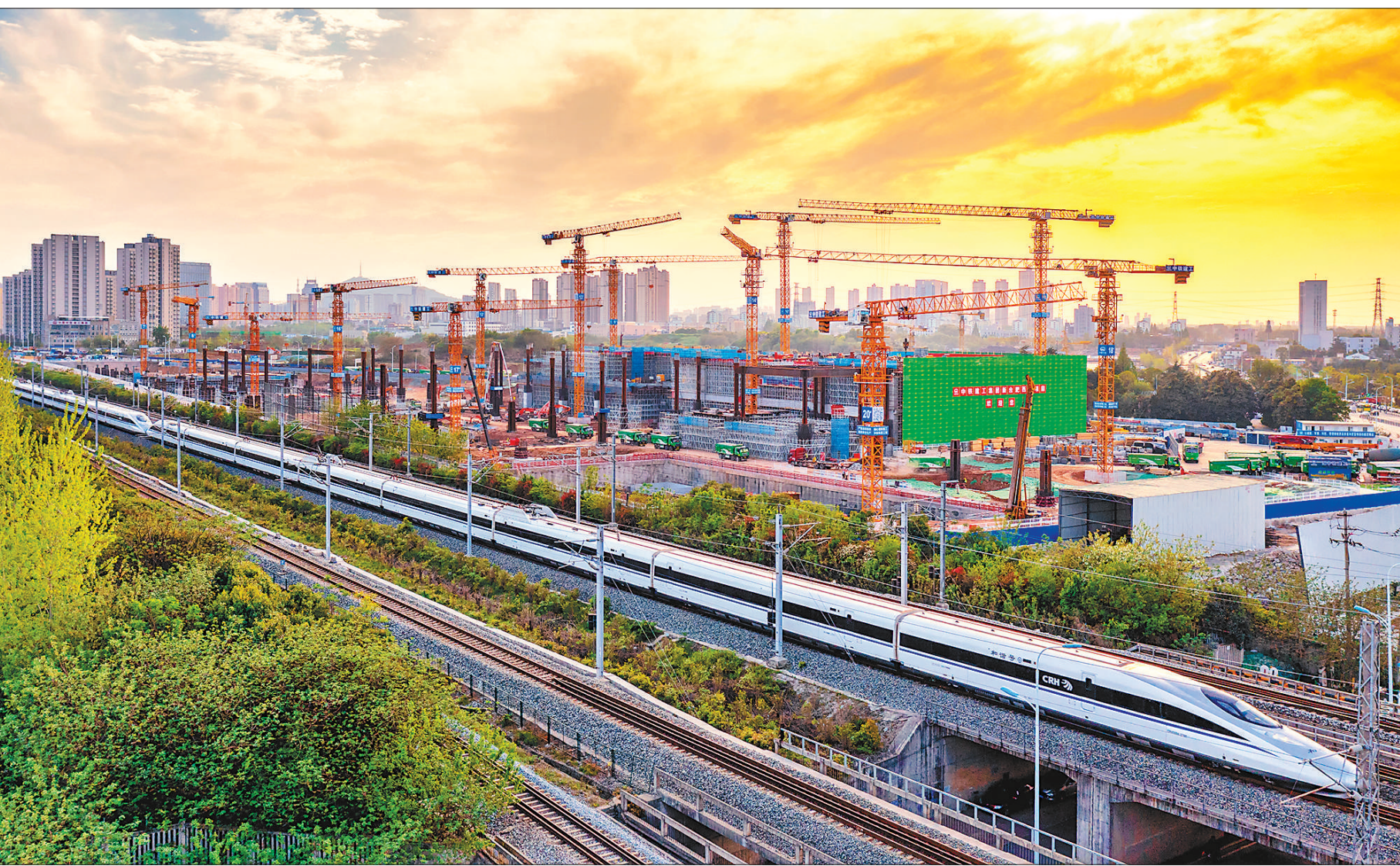
4月9日,安徽合肥西站站房主体结构工程施工如火如荼,项目综合开发及东广场项目超深基坑支护工程也在同步施工。据悉,合肥西站站场规模设计为8台18线,高架站房面积8万平方米,建成后将与合肥站、合肥南站共同构成合肥铁路枢纽“三足鼎立”的客运系统布局。 骆先洋摄(影像中国)
