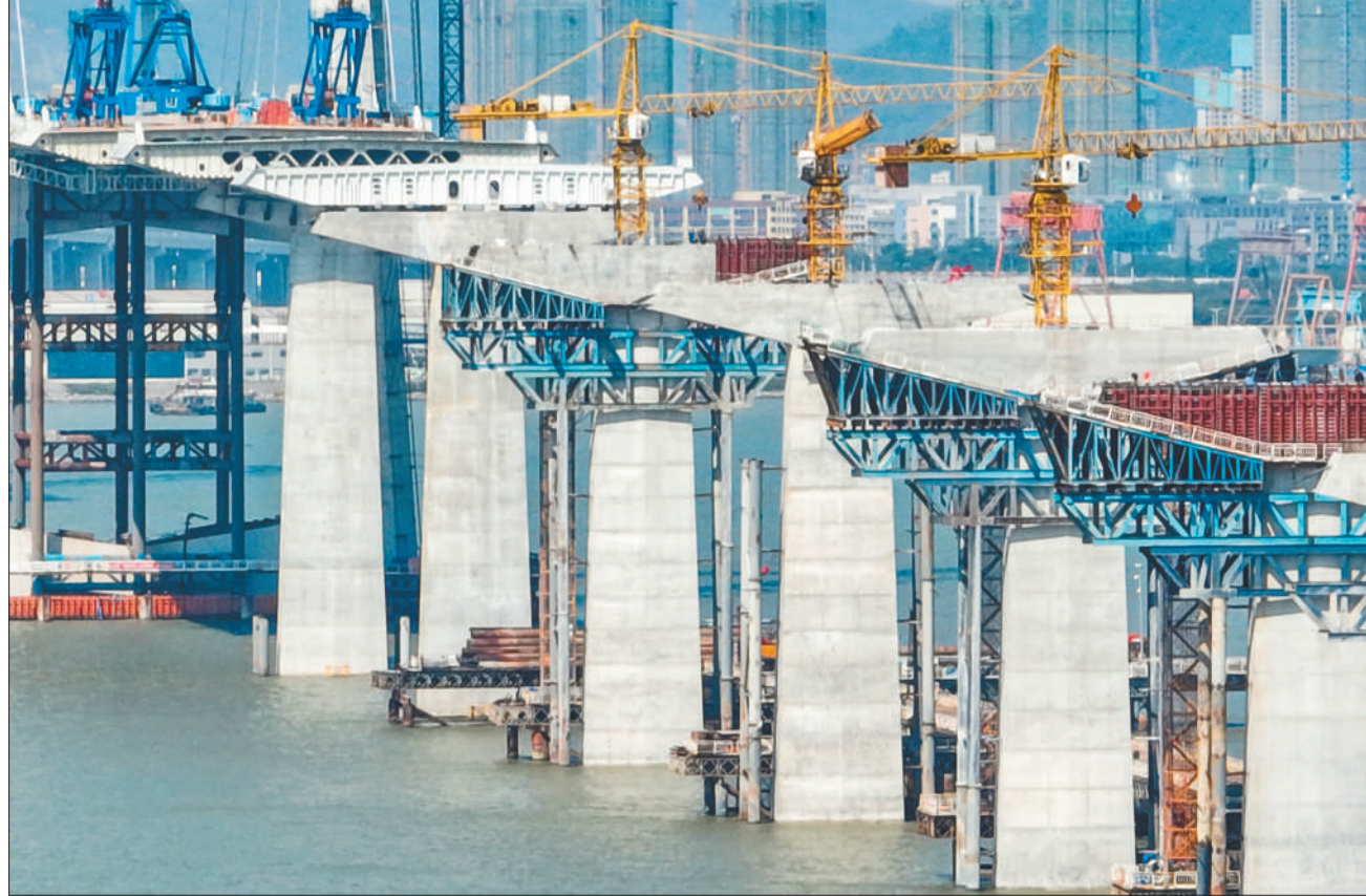
深中通道的集“桥、岛、隧、水下互通”于一体的跨海集群工程,项目全长24公里,其中海底隧道长约6.8公里,桥梁长约17.2公里,未来将成为粤港澳大湾区“大通道”的重要支撑。目前桥梁施工已完成所有引桥桩基础工程,西人工岛已完成筑岛,东人工岛已完成埋筑股临时性护岸构造工程施工。图为位于广东省广州市南沙区万顷沙南侧的深中通道,桥面施工正在有序开展。
