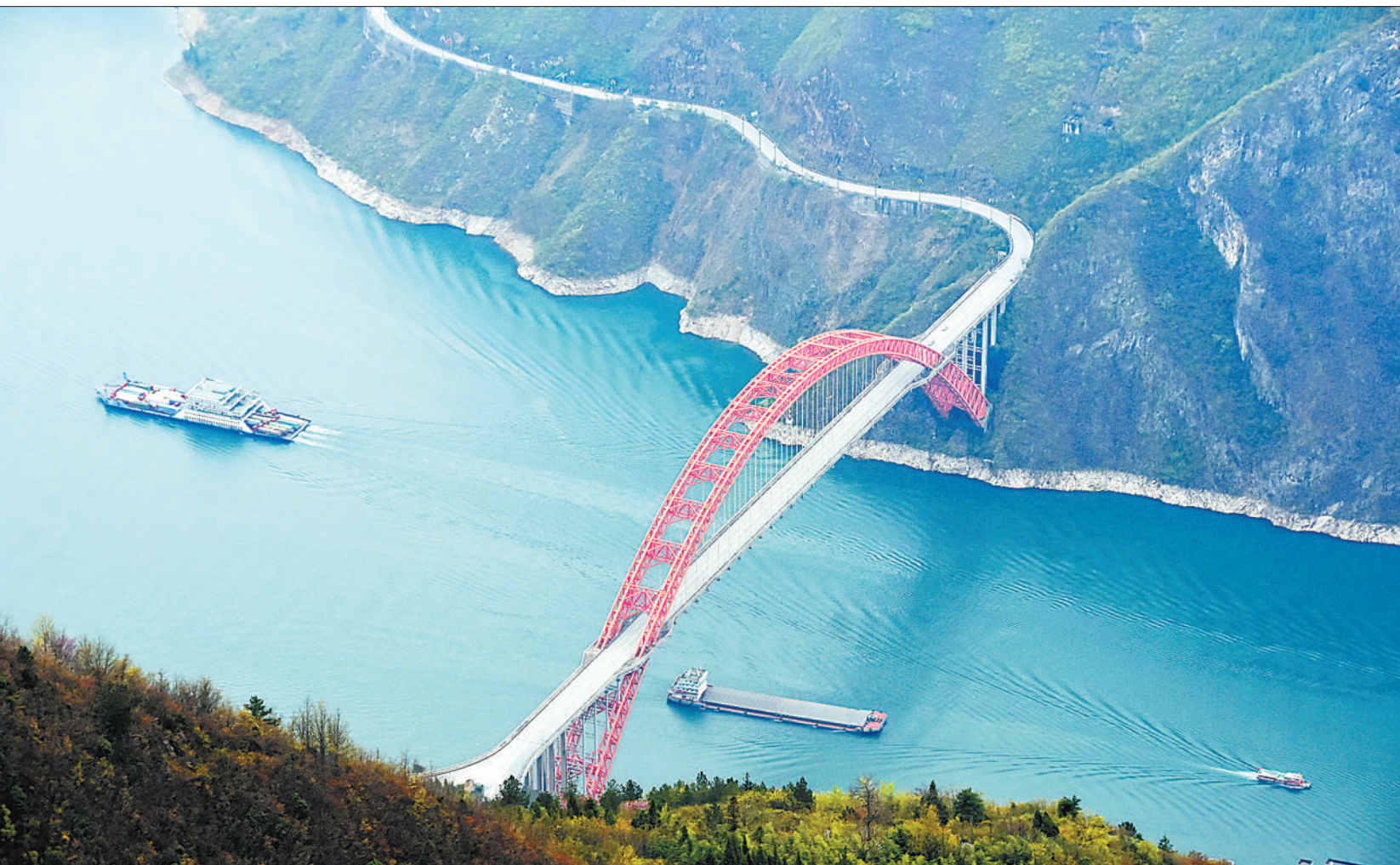
3月31日，重庆巫山县，轮船从长江大桥下驶过。近年来，位于长江三峡库区的巫山县加大交通基础设施建设力度，建成长江大桥、龙门大桥、桂花大桥、G42高速大宁河特大桥、郑万高铁大宁河大桥，昔日天堑变通途，“水陆空铁”立体交通枢纽逐渐形成。 王忠虎摄(影像中国)
